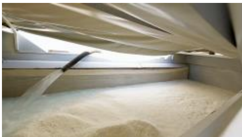
Automatisk udtag af kalkprodukt. Afvanding i dræncontainer og direkte genbrug
