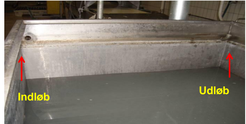
Manglende tilbagestrømningssikring på galvaniseringskar
